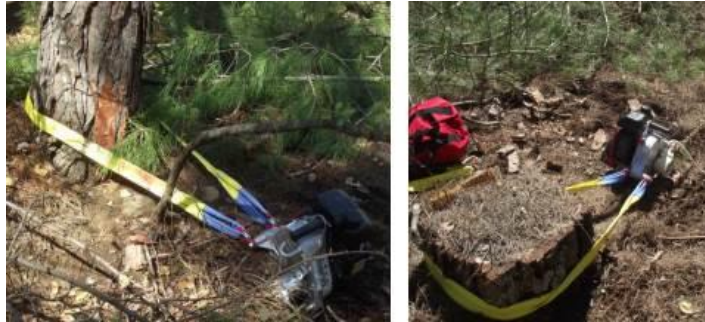
Şekil 3. Benzinli el vinci kurulumu
